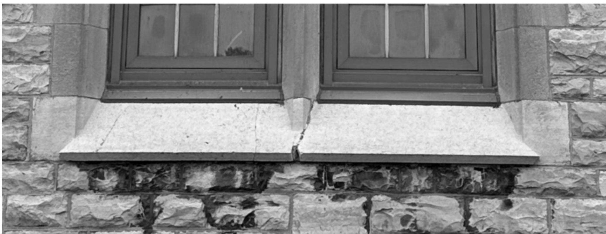
9 FORT LASALLE - REPLACE STONE SILL SCALE: 1:1
