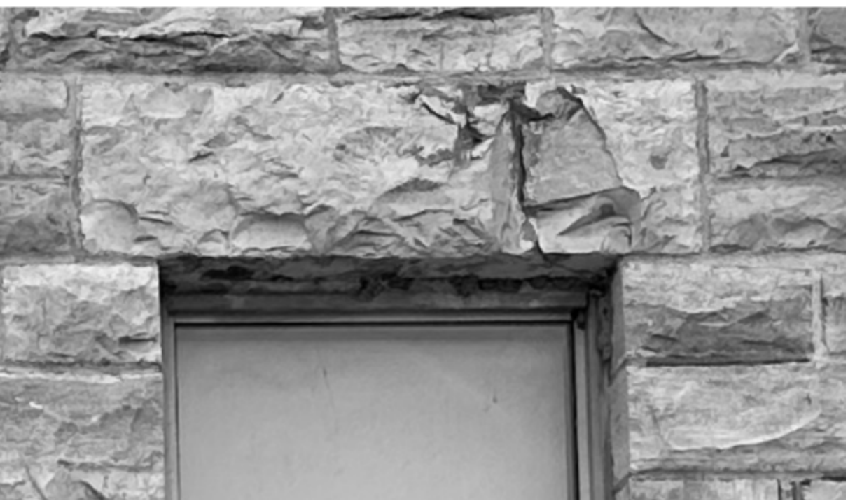
8 FORT LASALLE - REPLACE LINTEL STONE SCALE: 1:1
